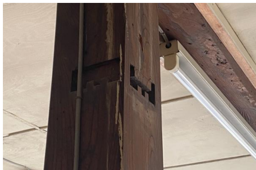
図1 柱に残る鴨居の痕跡（筆者撮影）
