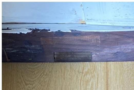
図2 梁に残る柱の痕跡（筆者撮影）
