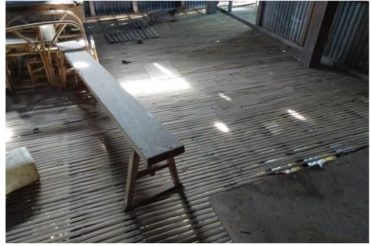
図9 増築された竹床の台所 (江面嗣人撮影)
